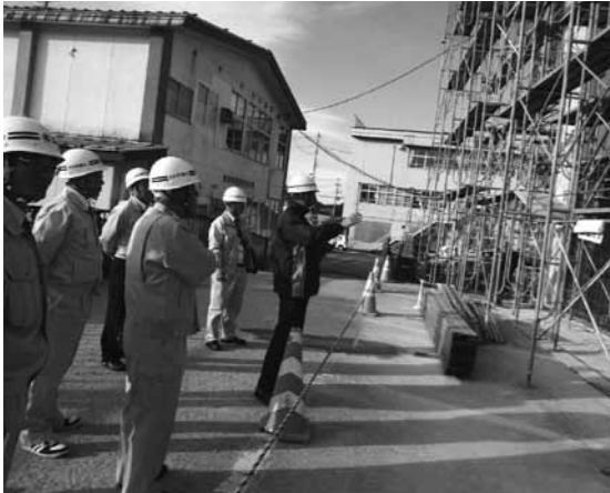
庁舎耐震工事
