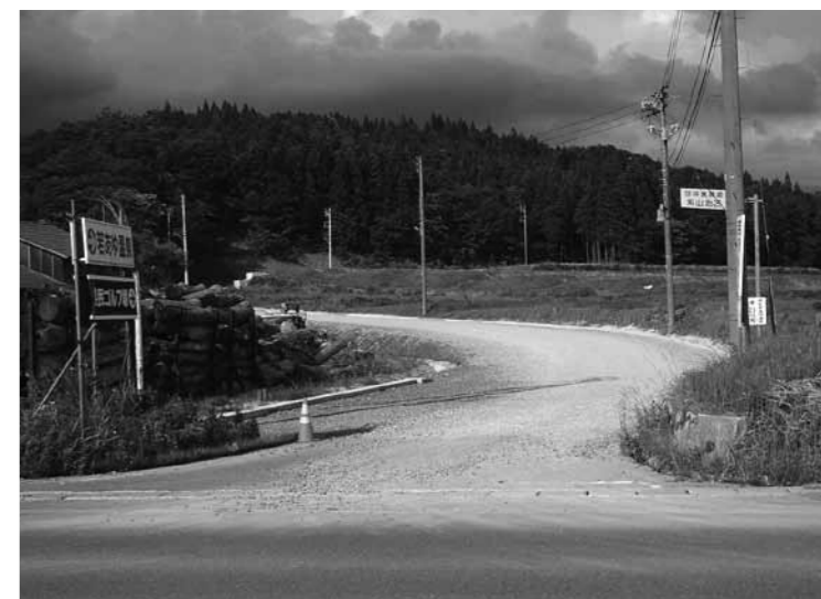
工事中の温泉入り口(紫山)
