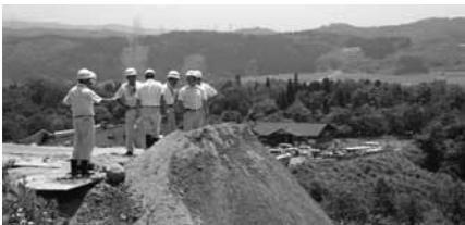
若あゆ温泉災害現場
