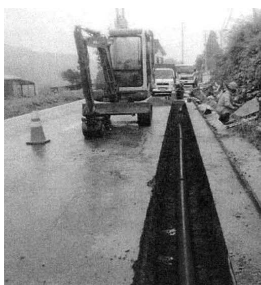
石綿管布設替え工事
