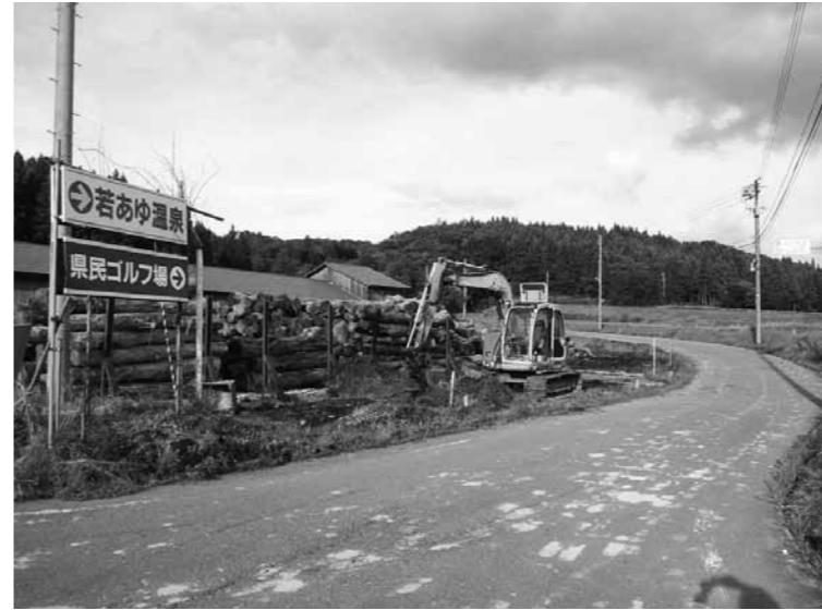
温泉入り口の拡幅工事
