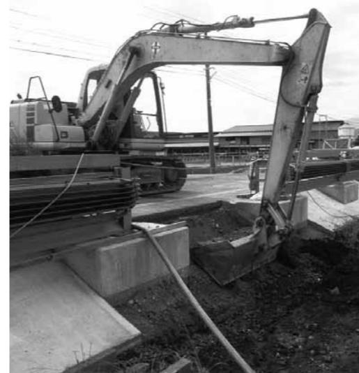
水道管入れ替え工事
