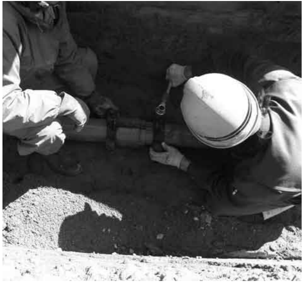
災害復旧工事（紫山）
