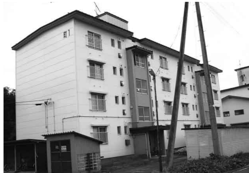
町営住宅1号棟
