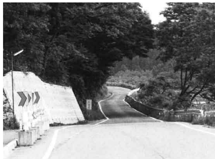
見通しが悪く幅員が狭いので対面通行ができない状況 (主要地方道大石田畑線・本堀内地区)
