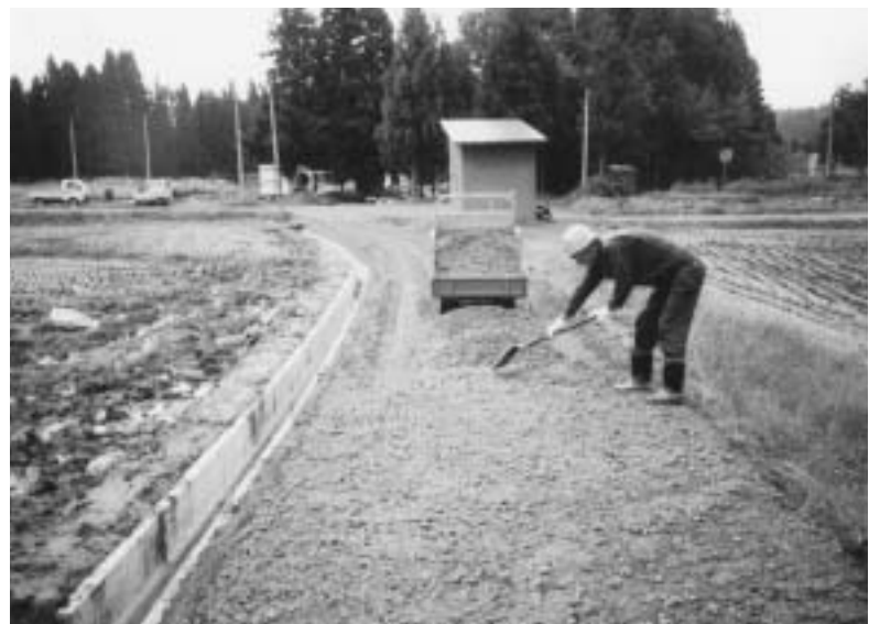
中山間支払い制度による工事
