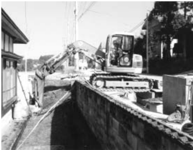
完了した下水道工事（紫山地内）
