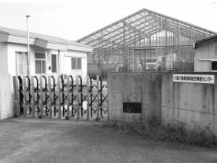
井戸掘削が待たれる鮎中間施設
