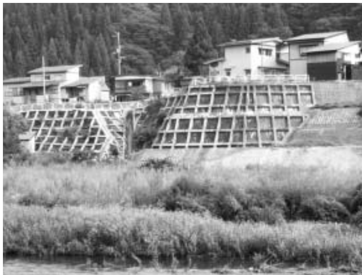
完成した急傾斜事業法面保護工事（平石地区）
