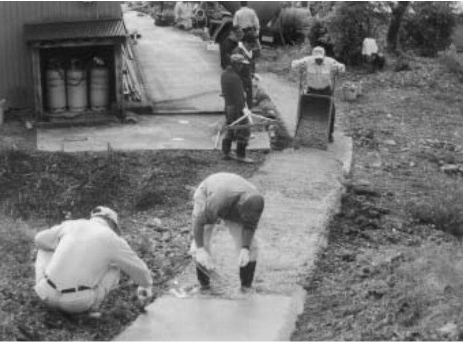
協働の町づくり工事で、通学路整備（幅地内）
