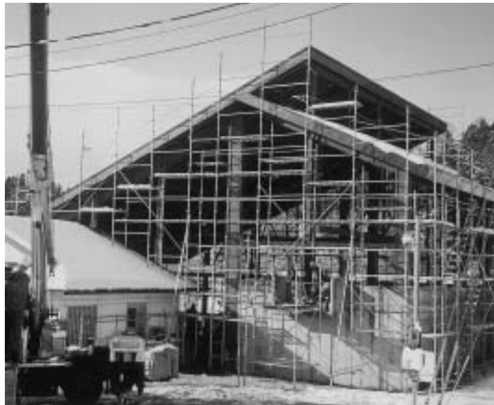
集落排水工事、長者原、福寿野地区処理場
