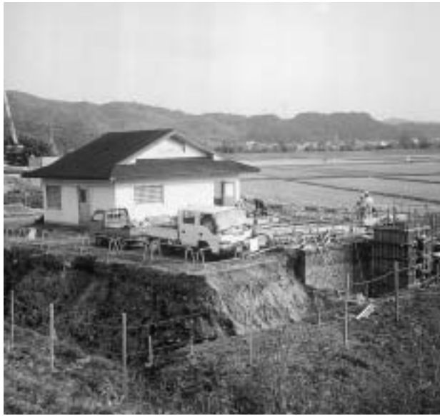
改修工事がはじまっています (福寿野地区農集排施設)
