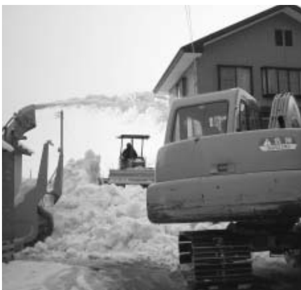
連日の雪のため道路確保に行われた排雪作業
