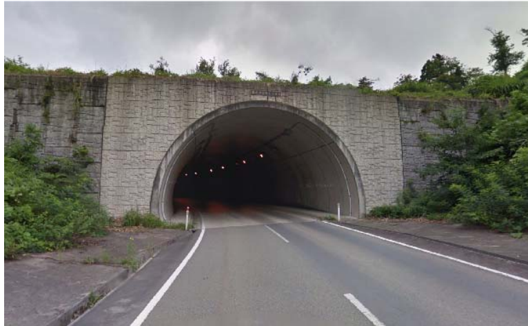
若あゆ温泉トンネル（2000年竣工）
