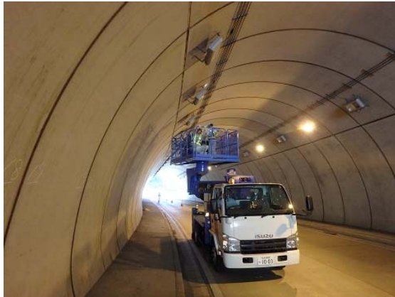
大型ボックスカルバート 初回点検状況
