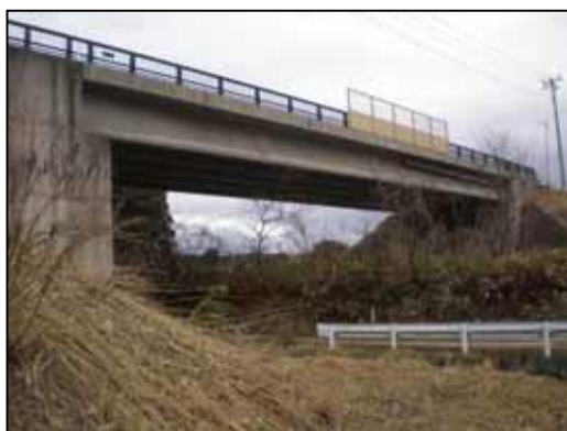
図4-3 跨線橋 (向山跨線橋)
