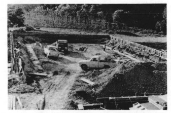
着々進められている工事現場
