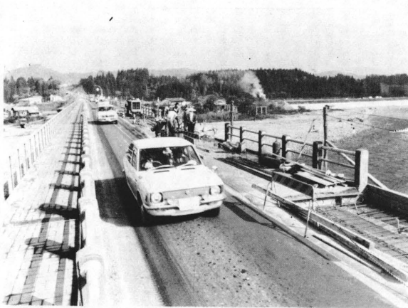
年々増大する交通量、ジャンボ化する自動車、もはや補修工事のみでなく、現代にふさわしい架橋が叫ばれている……………。
