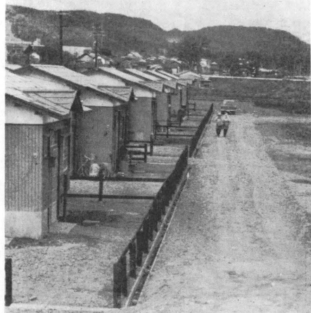
下河原地区の公営住宅 道路右側に45年度分建設
