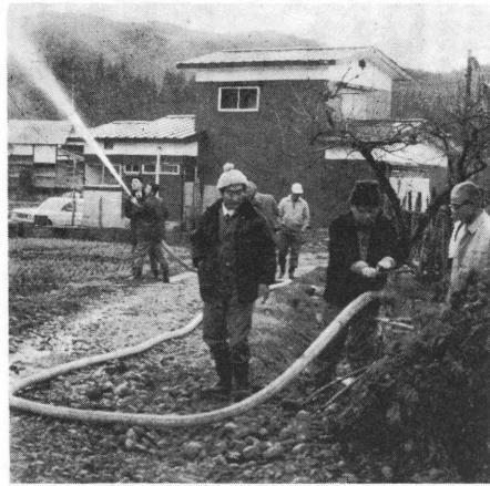
進む水道事業 消火栓の点検
