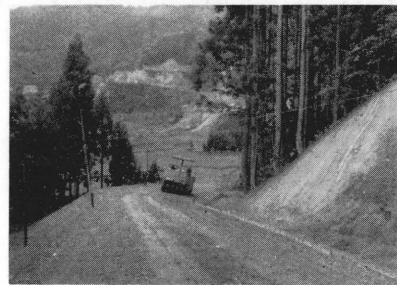
毎年計画的に町道の整備が進められている。43年度には道路橋梁費に2,331万円が支出され、道路改良、側溝整備、橋の架換が行なわれた。
