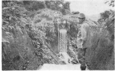
三光堰約三十米が欠壊し、下流四百五ヘクタールの水田は一滴の水もない(内山で)
