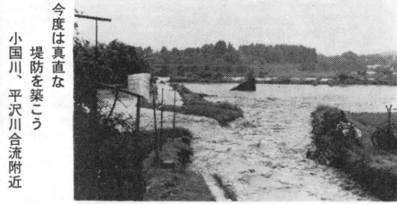
三光堰約三十米が欠壊し、下流四百五ヘクタールの水田は一滴の水もない(内山で)
