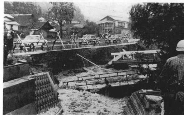
橋梁、国道も大きくえぐりとなった平沢川(舟形一で)
