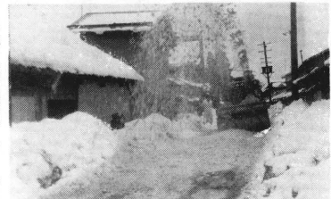
舟形・堀内間にブルドーザーをおく
