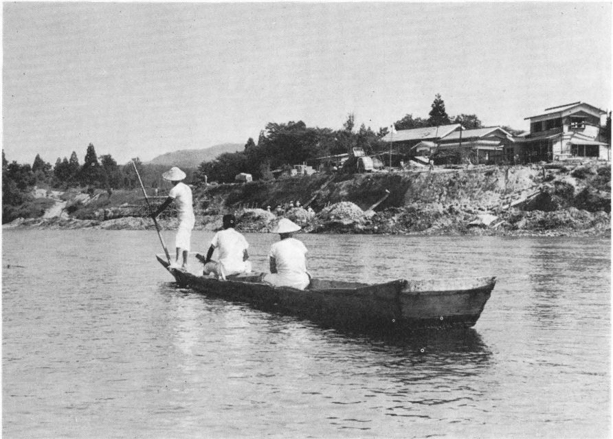
(写真は 堀内地区最上川畔築堤工事現場)
