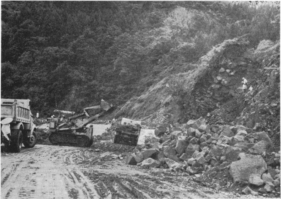
(写真は47号線 通称「サエノカミ」工事現場)
