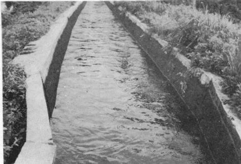
地震発生により亀裂を生じた三光堰水路
