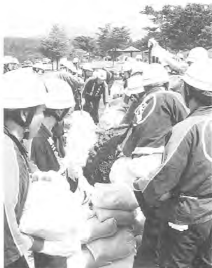
積土のう工法による水防作業
