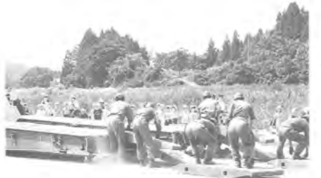
自衛隊第6師団による 架設橋の設置
