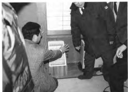
冷風吹き出し口。各部屋にこの吹き出し口と貯雪槽に戻す吸い込み口が設置。場所をとらずシンプルな構造。
