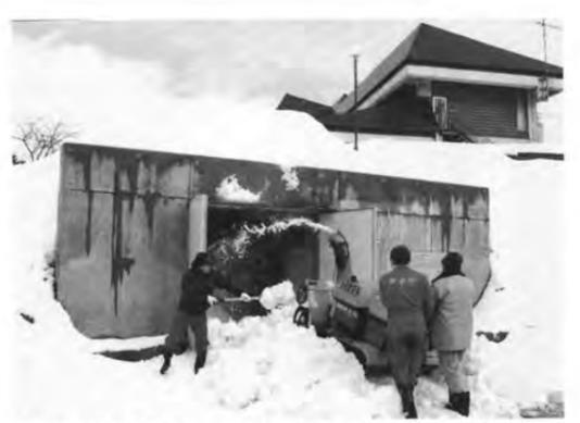
貯雪槽（ピット）への雪入れ作業。実習館の中庭と駐車場の段差を利用して設置。約60トンの雪を3日かかりで詰め込む。
