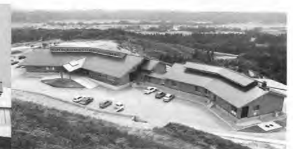
◀医療サービスセンター&観光物産センター
