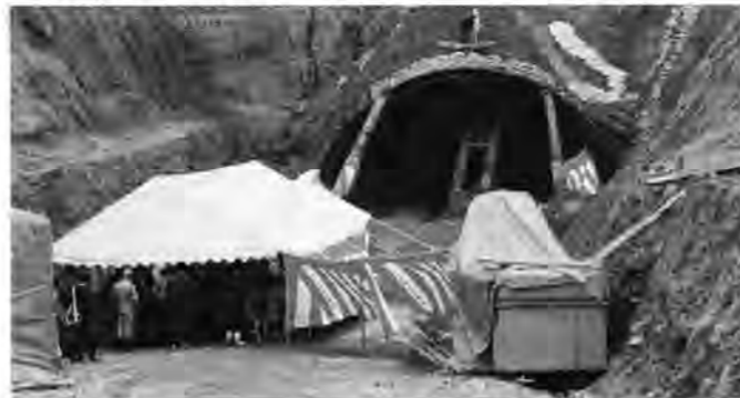
▼本格工事に着工した舟形トンネル（西堀地内坑口）
