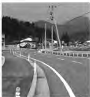
地域幹線道路の整備 生活道路の整備、新幹線踏切改良工事
