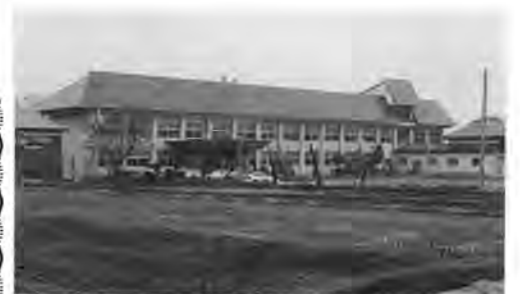
(改修された堀小校舎)
