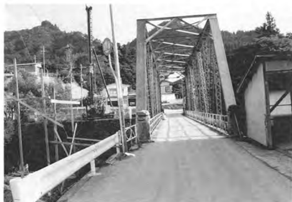
◀ 長沢橋架替工事着工
