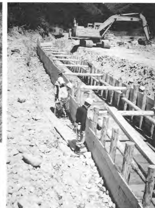
▲急ピッチで進む導入路工事
