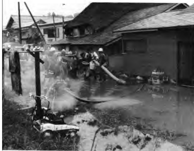
▼堀内川端で懸命の排水作業を消防団員
