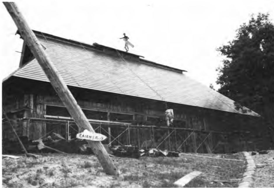
▲ 猿羽根山に建設中の歴史民俗資料館
