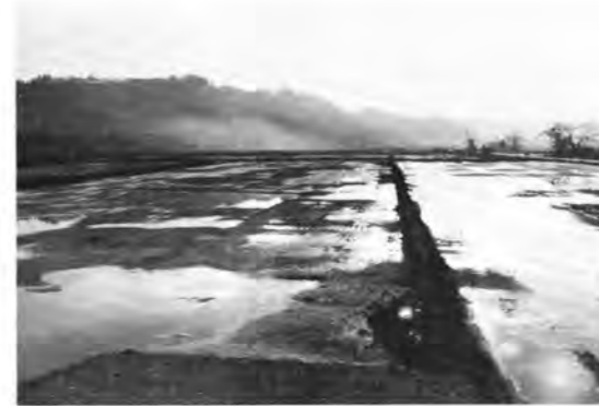
▲ ハリヨ地区亜炭鉱害復旧事業完成
