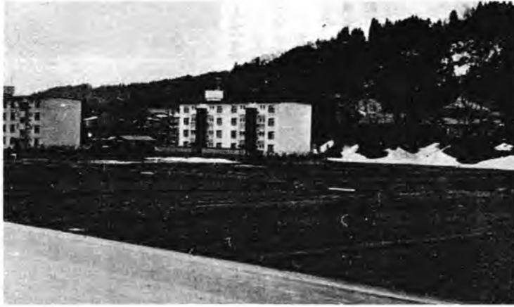
町営住宅完成 郵便局簡易保険より多額の融資
