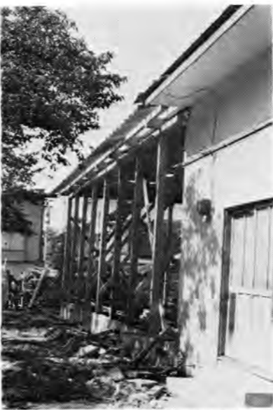
(工事はじまった保育所増改築)
