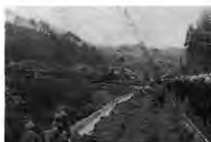
48年に起きた平沢地区地すべり現場
