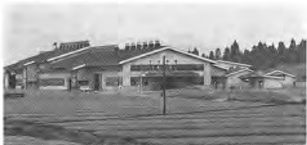
(近代的な公害防止設備をもつ工場全景)
