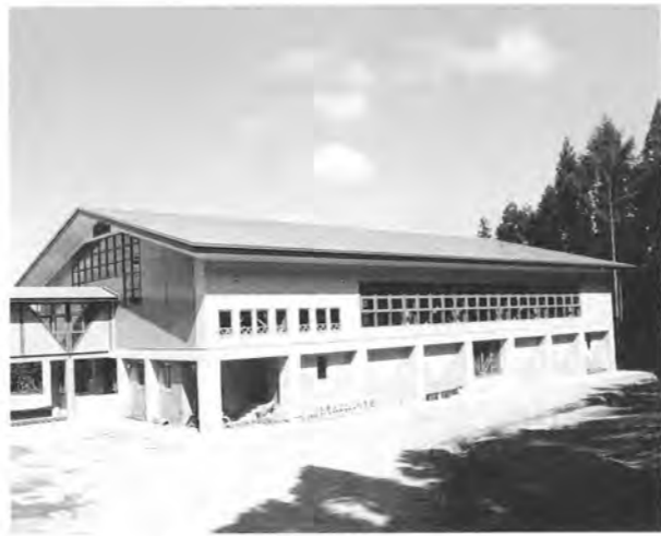
▲完成したばかりの屋内運動場
