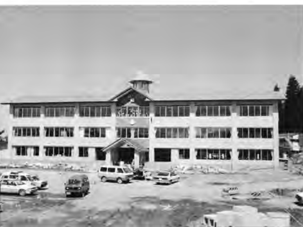
改築された富長小学校校舎
