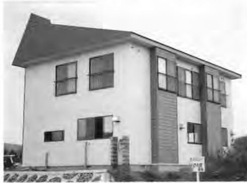
▲堀内地区農業構造改善センター
