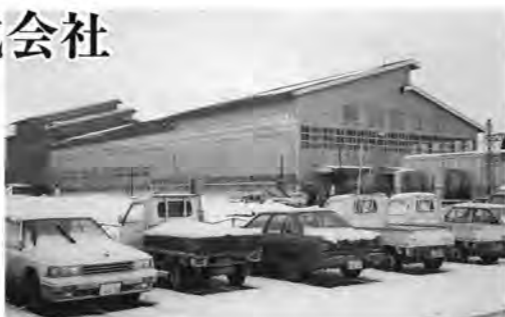
▲建設中の新工場
