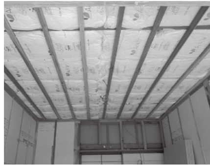
断熱材施行中のあったか100歳住宅
