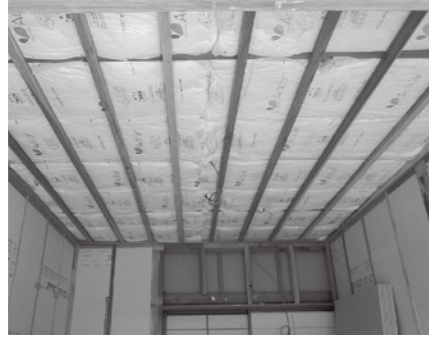
断熱材施行中のあったか100歳住宅
