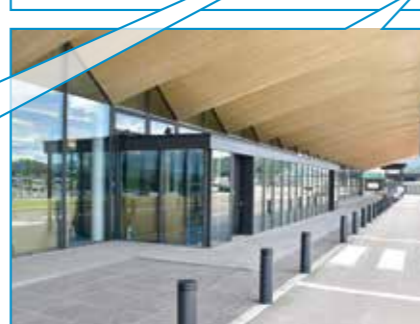
▲①正面出入口の様子。正面出入口のご利用は平日午前7時30分から午後5時まで。その他の時間は⑤の夜間休日出入口をご利用ください。
