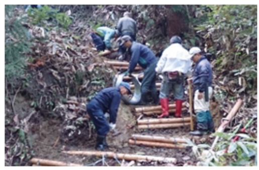
七夕神社参道復旧作業
