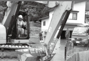
▲土砂流入の復旧作業
