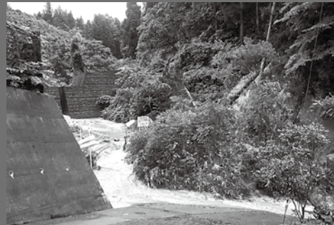
▲舟形第1の急傾斜地の崩壊
