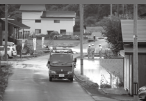
▲消防団(水防団)による排水作業
