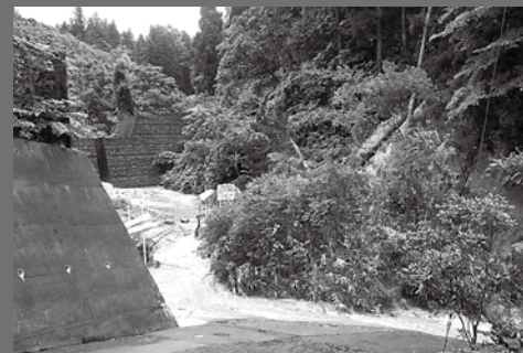
▲舟形第1の急傾斜地の崩壊
