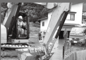
▲土砂流入の復旧作業
