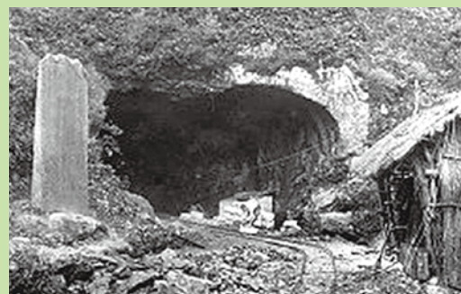
▲明治14年に開通した初代栗子隧道米沢側坑口
