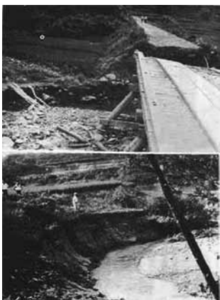
写真上は橋ぎわをえぐりとられた 老の沢橋と道路 写真下は鉄砲水でえぐられた 実栗屋川の欠壊場所
