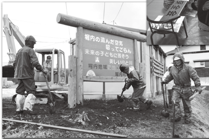
看板設置の様子
