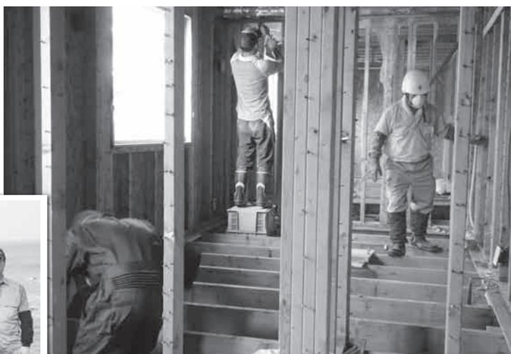
津波で被災した住宅を補修中
