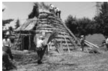
あゆっこ村の縄文式住居の屋根の葺き替え作業が、長沢親和会が中心となり実施されました。
