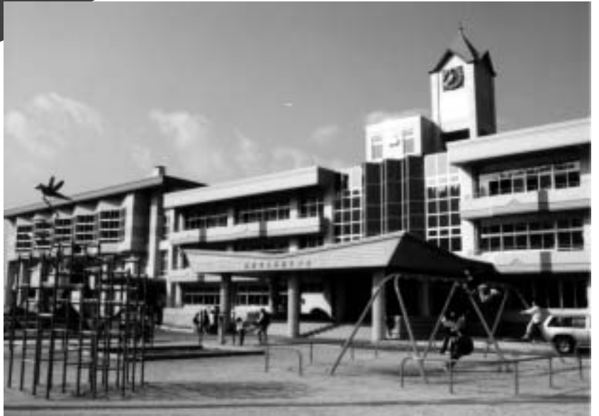
鉄筋コンクリート3階建ての新校舎に子供たちも大喜び
