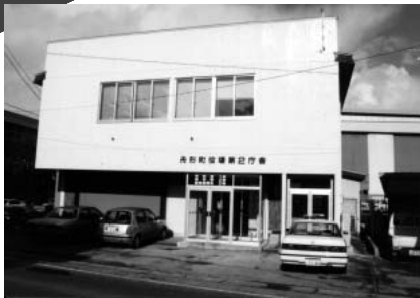
役場第2庁舎完成
