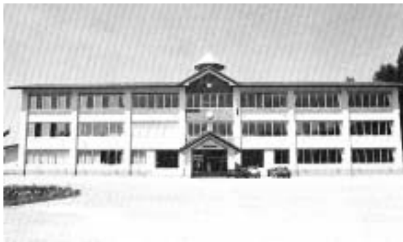
富長小学校新校舎完成
