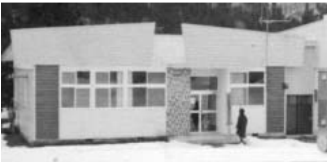
完成した堀内診療所
