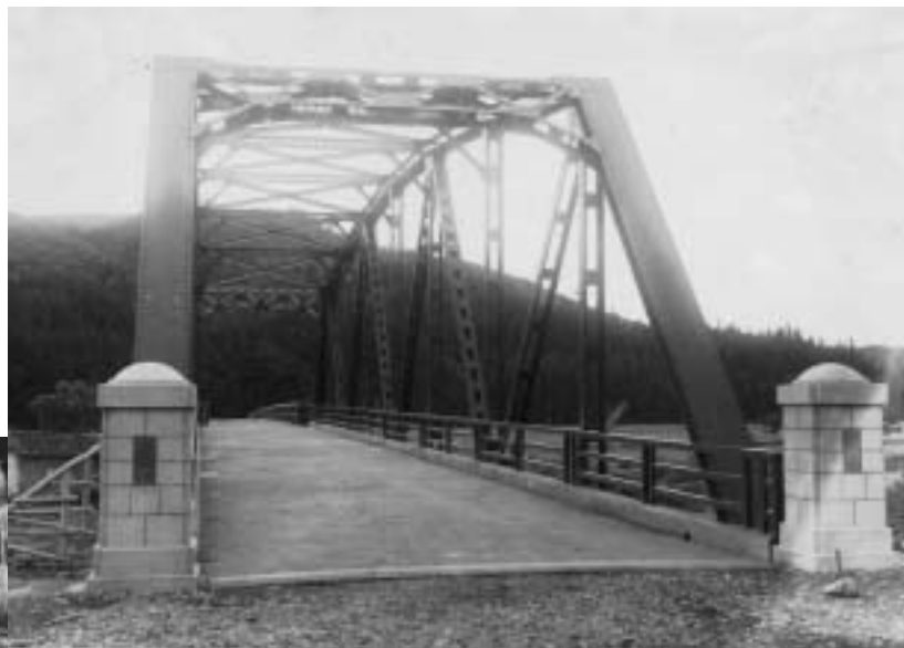
完成した富長橋（半分は昭和26年完成）
