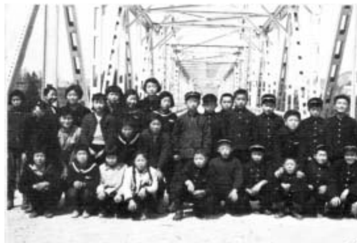
完成した堀内橋
