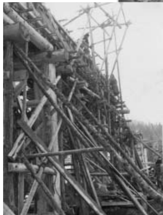
建設中の富長橋（S34）
