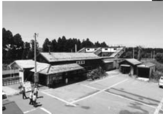
解体前の舟形駅
