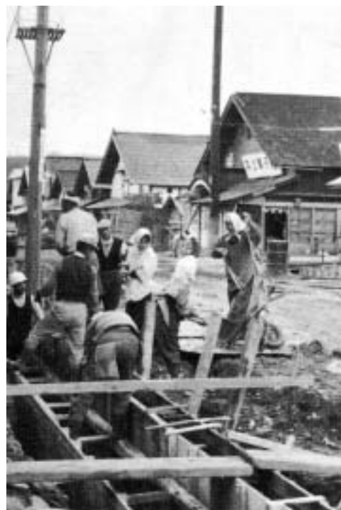
当町初の流雪溝工事
