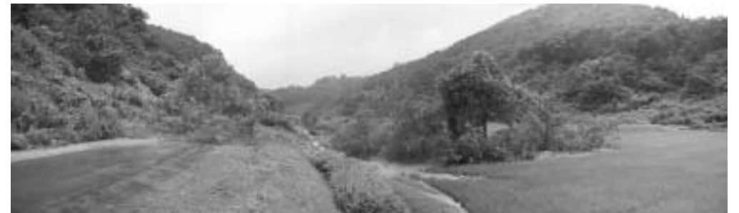
法面が崩壊し、土砂が道路を越えて、水田まで達している（7.17水害）
