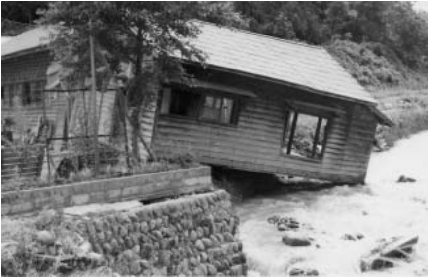
増水により土台が削り取られ、傾いた西又教職員宿舍（Ｓ５１.８.６）
